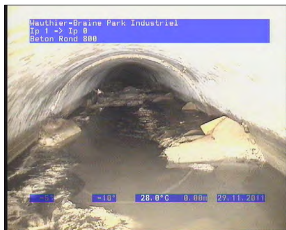
Foto: 2_2B, 00:00:01 0,1m, Bezonken afzettingen, hard of vast, hoogte: 55 %, klok: 3 - 9 , Start
