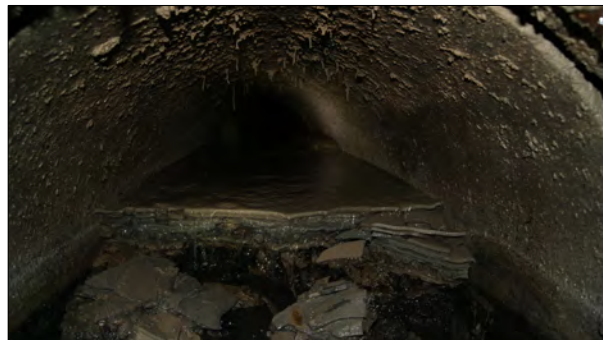
Foto: 6_2A, 00:00:00 0,01m, Bezonken afzettingen, hard of vast, hoogte: 50 %, klok: 3 - 9 , Start //20% slib --30% cement
