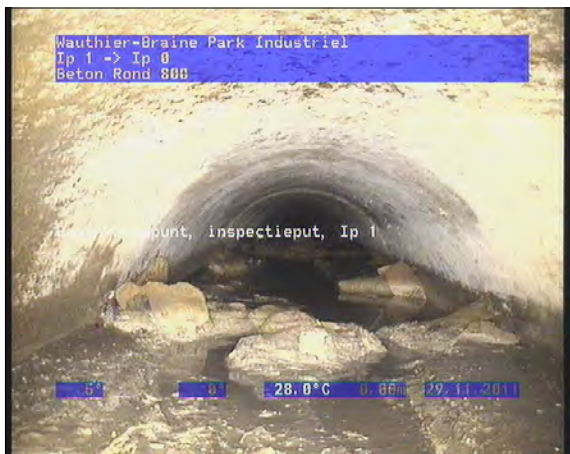
Foto: 2_1A, 00:00:00 0m, Beginknooppunt, inspectieput, Ip 1
