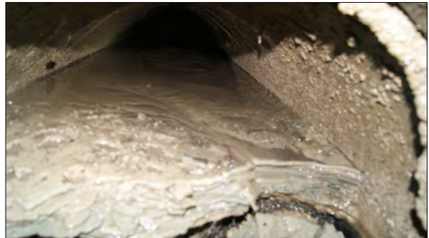
Foto: 5_2B, 00:00:00 0,2m, Bezonken afzettingen, hard of vast, hoogte: 50 %, klok: 2 - 10 , Start // Volledige streng
