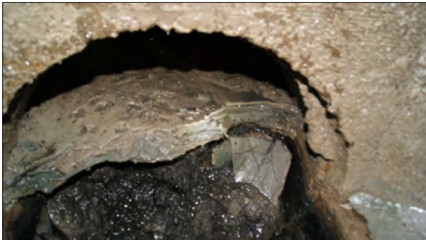
Foto: 5_2A, 00:00:00 0,2m, Bezonken afzettingen, hard of vast, hoogte: 50 %, klok: 2 - 10 , Start // Volledige streng
