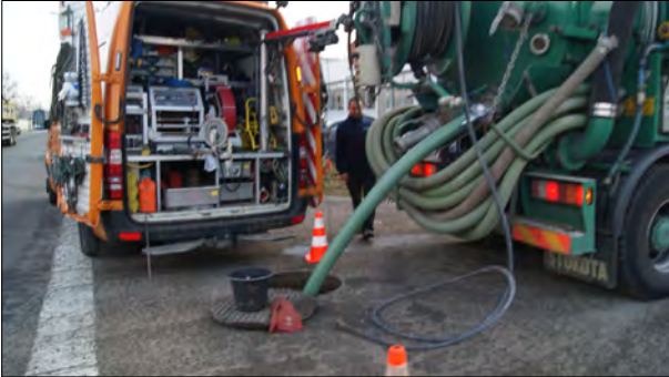
Foto: 1_1A 0m, Beginknooppunt, inspectieput, Ip 1
