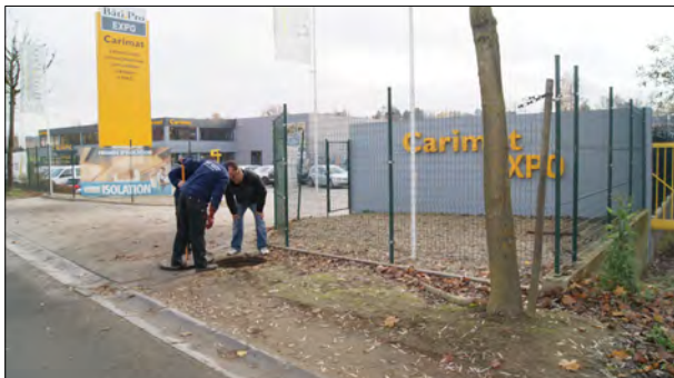
Foto: 6_1A, 00:00:00 0m, Beginknooppunt, inspectieput, lp 7
