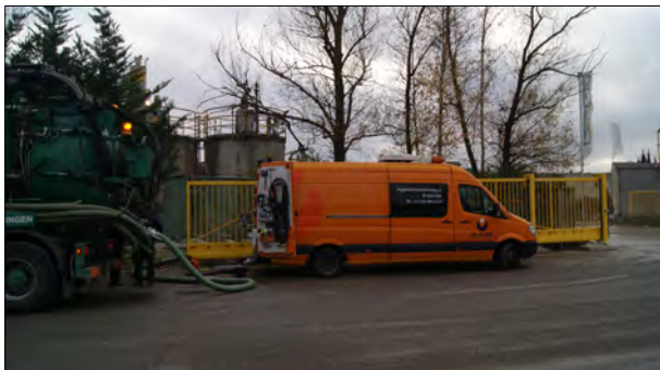
Foto: 3_1A, 00:00:00 0m, Beginknooppunt, inspectieput, Ip 5
