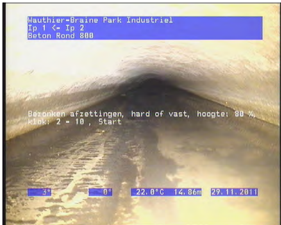
Foto: 1_7A, 00:03:38 14,86m, Bezonken afzettingen, hard of vast, hoogte: 80 %, klok: 2 - 10, Start
